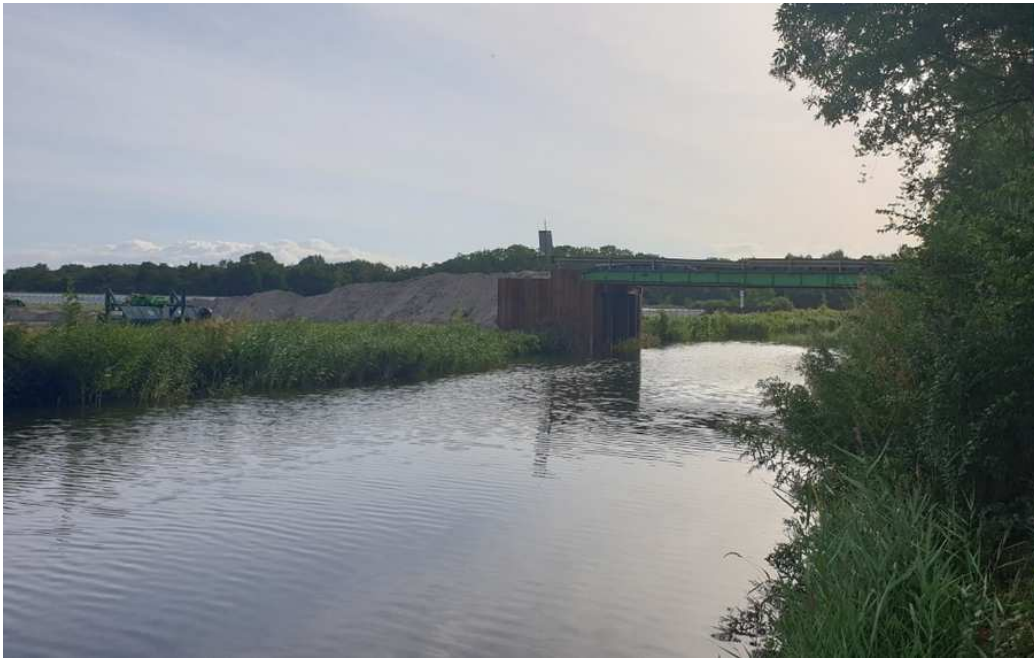
Figuur 2.2 Foto tijdelijke brug aanlegfase
