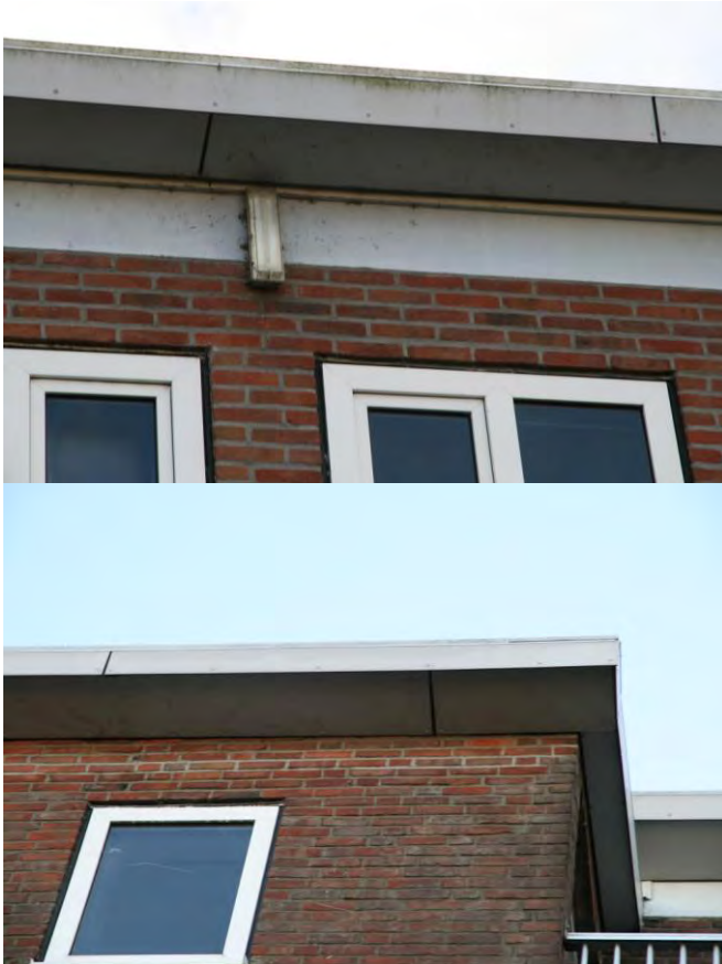
Foto 4 en 5 (A&W). Foto 4. Betonnen balk onder de dakgootbetimmering. Foto 5. Dakgoot die nader geïnspecteerd dienen te worden.
