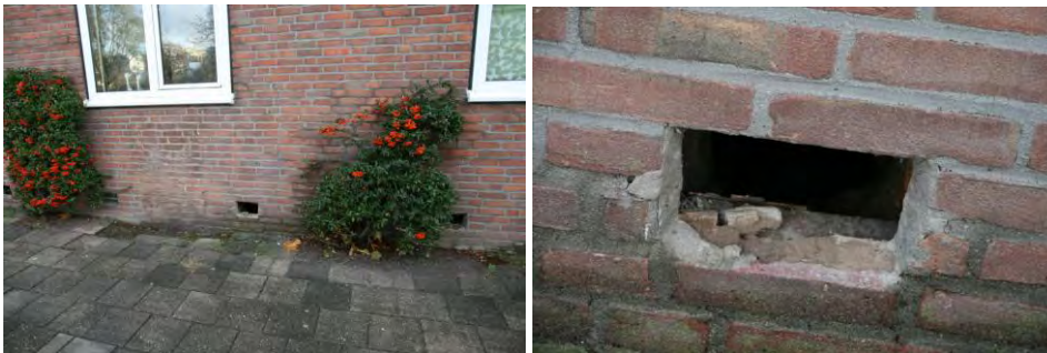
Foto 6 en 7 (A&W). Gaten in de muur van het flatgebouw aan de Haagdoornplein.
