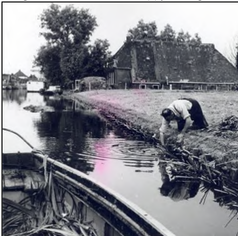
Figuur 2.3: Walbeschoeiing achter Het Vliet, achter de Vuurdoornstraat, bij de voormalige schiphuizen Lange Negen
