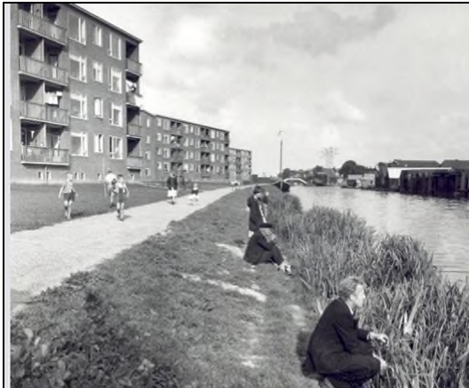
Figuur 2.7 : Achterzijde van de flats aan de Vuurdoornstraat, langs het Vliet gezien naar de Schilkampen (Sj. Andringa, foto 1995)
