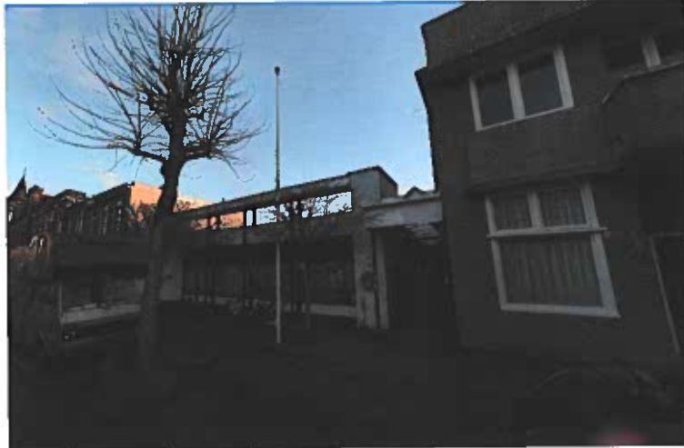
Huidige pand aan de wegzijde
