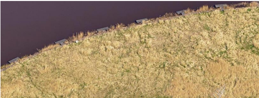
Reeds aanwezige steigers
