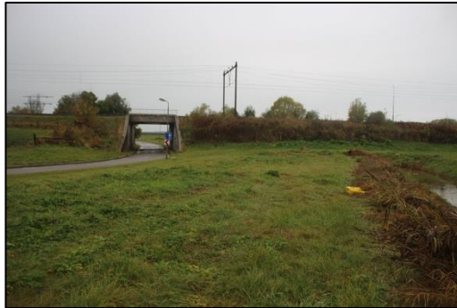
Afb. 3.14: Startpunt ten oosten van de spoorverbinding.
