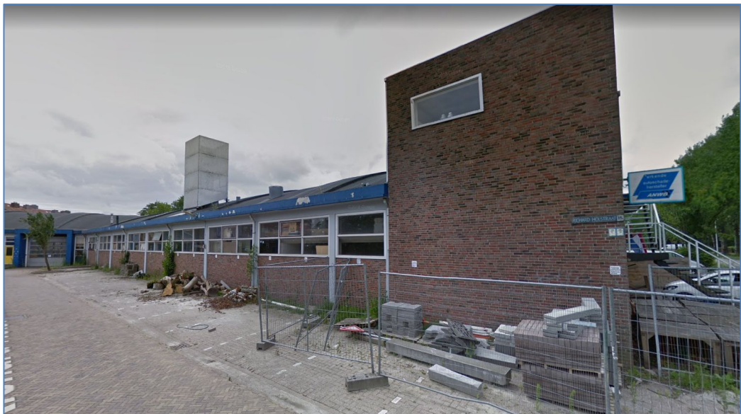
Figuur 2.2: Een aanzicht van de bestaande te slopen bedrijfsloods gezien van de Richard Holstraat.
