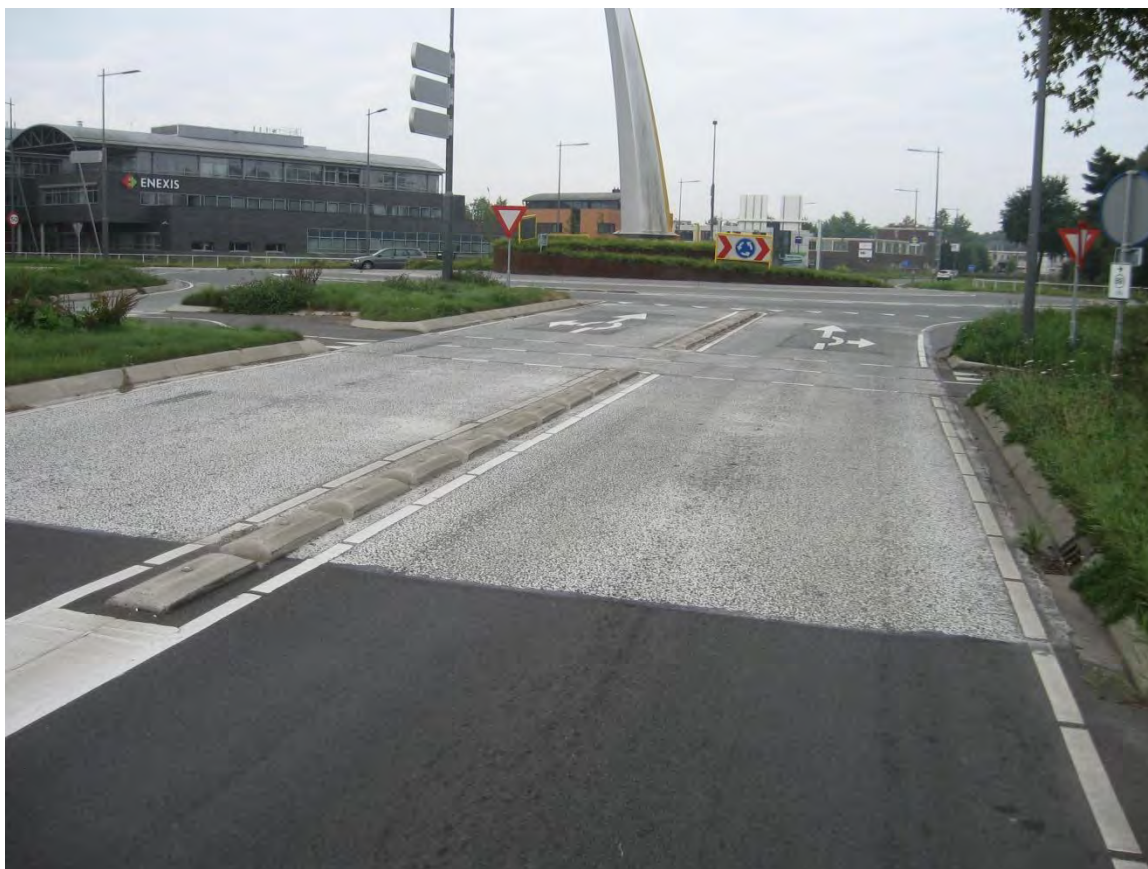
Gemeente Weert, Eindhovenseweg/Ringbaan Asphaltverharding met combinatiedeklaag(aanlegjaar 2012)
