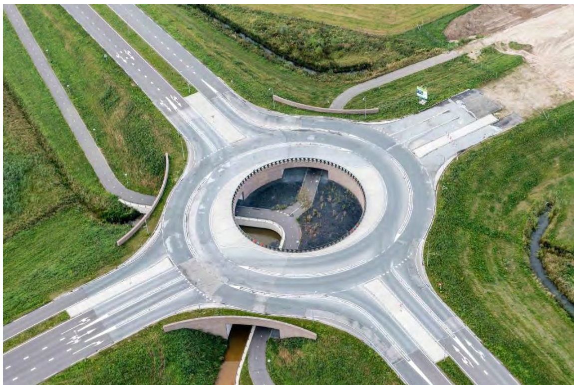
Gemeente Den Bosch, de Groote Wielen; asfaltverharding met combinatiedeklaag
