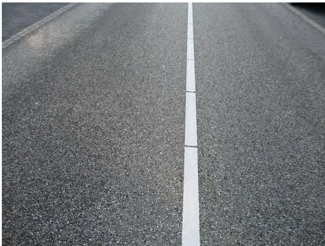
Gemeente Kerkrade, Locht: SMA met 20% witte steenslag (Luxovit) en zwarte bitumen
