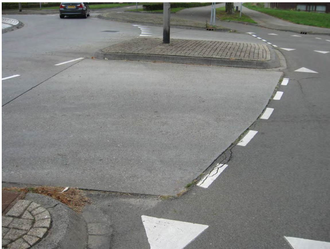
Gemeente Weert, Eindhovenseweg/Noordkade; doorgaand gewapend beton (aanlegjaar 1998)
