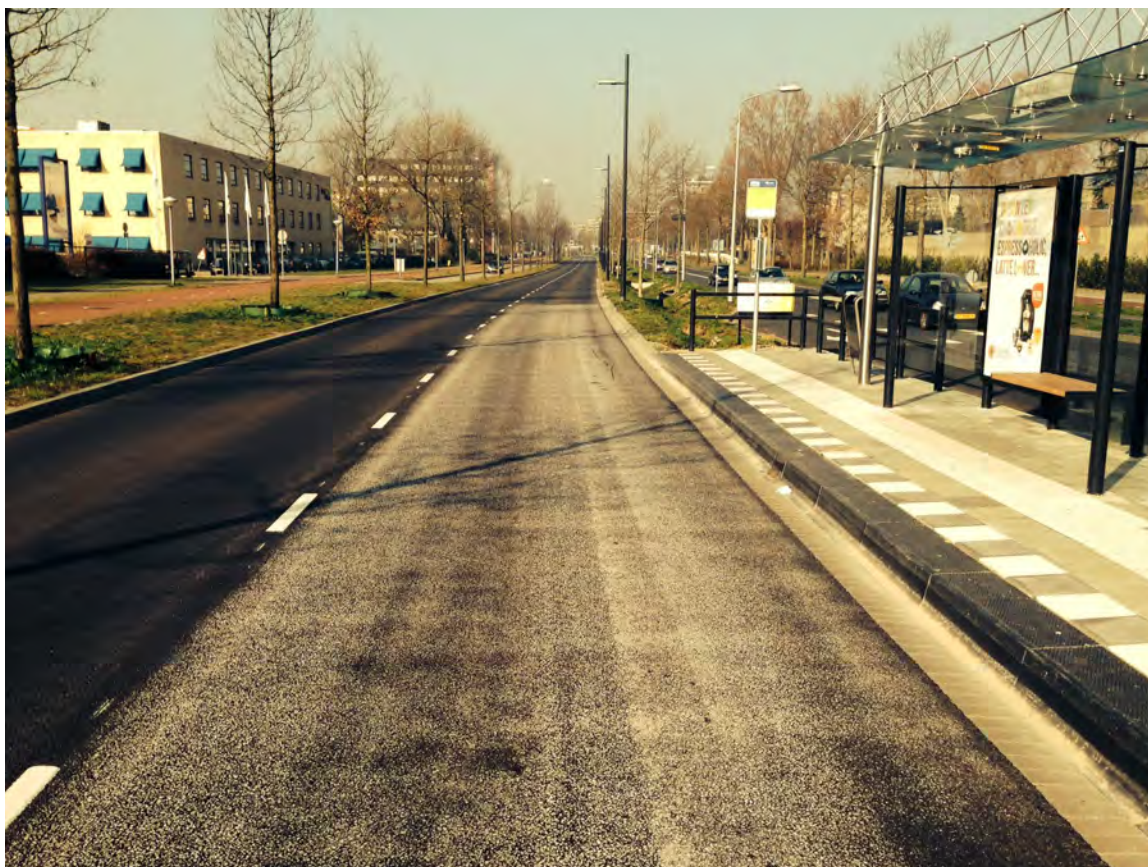
Gemeente Eindhoven, Busbaan Sterrenlaan: SMA-NL 8B met 60-70% Reflexing White en zwarte bitumen
