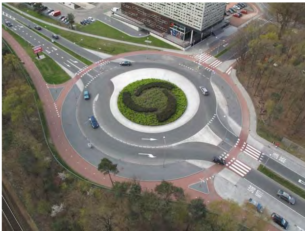
Gemeente Hilversum, Mies Bouwmanboulevard; asfaltverharding met deklaag van 'normale' SMA
