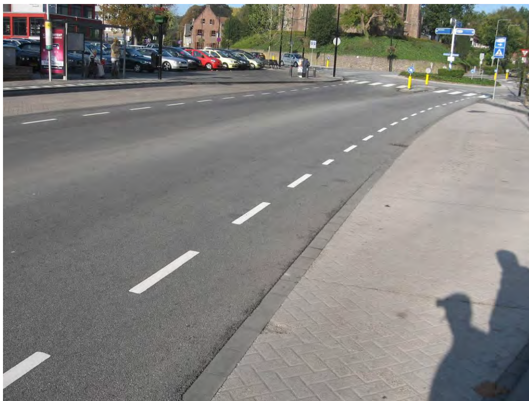
Gemeente Kerkrade, Veldhofstraat SMA 0/8 met 100% witte steenslag (Reflexing White) en zwart bitumen.
