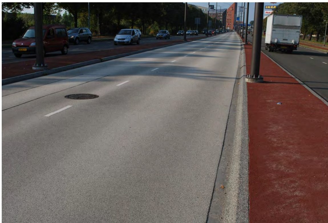
emeente Groningen, Busbaan Europaweg: SMA-NL5 met 100% Reflexing White en blanke bitumen
