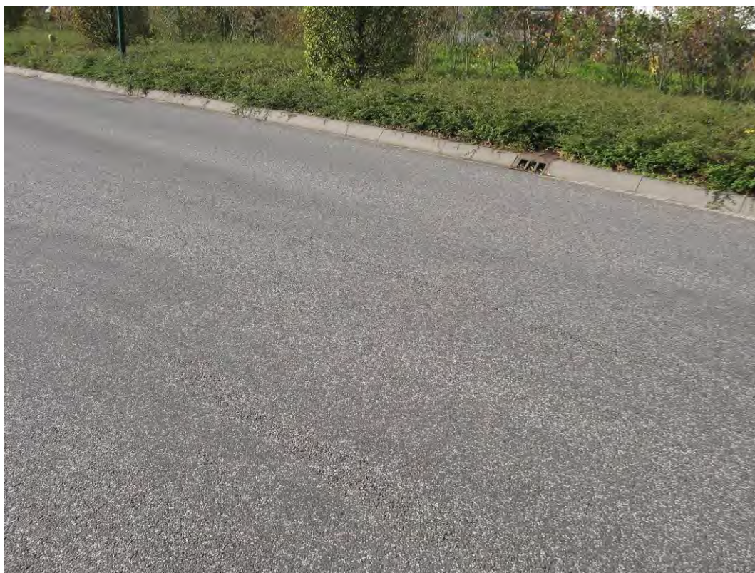
Gemeente Nuenen, De Huufkes: DAB met 30% witte steenslag (Luxovit) en zwart bitumen
