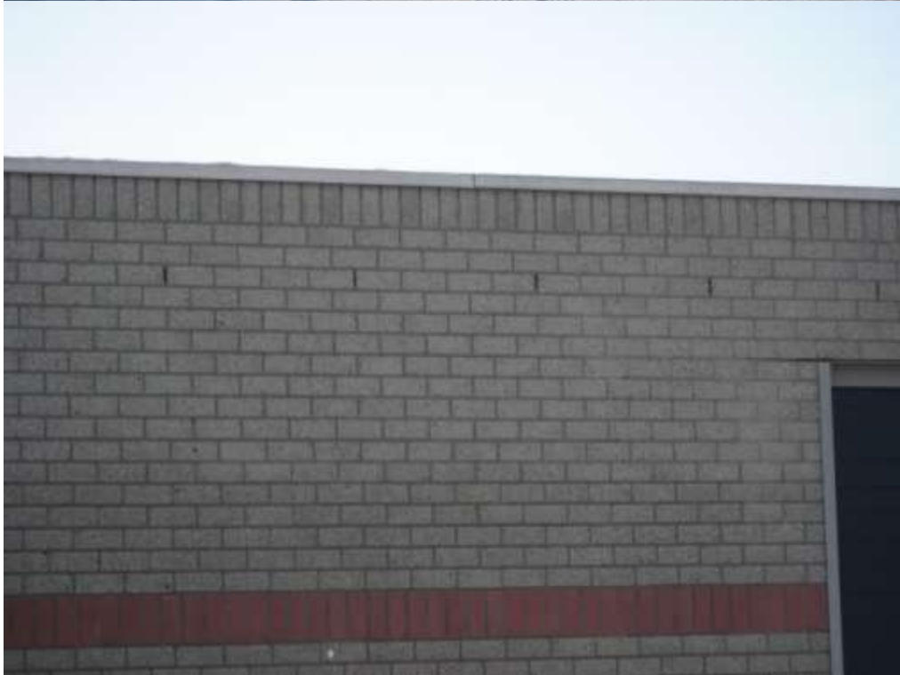
Foto's 2 en 3. Het gebouw dat potentieel geschikt is voor verblijfplaatsen van vleermuizen. Foto 3 de stootvoegen die mogelijk toegang tot de spouw bieden.
