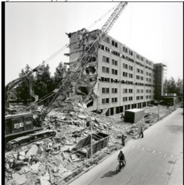
Figuur 2.4: Foto sloop flatgebouw Eekswerd (Fotonummer FDDMEENTB004; bron HCL)
