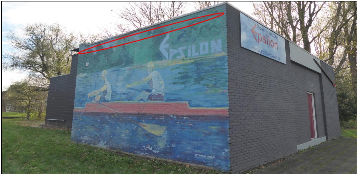
Figuur 2.4. Stootvoegen bij het gebouw van de roeivereniging.
