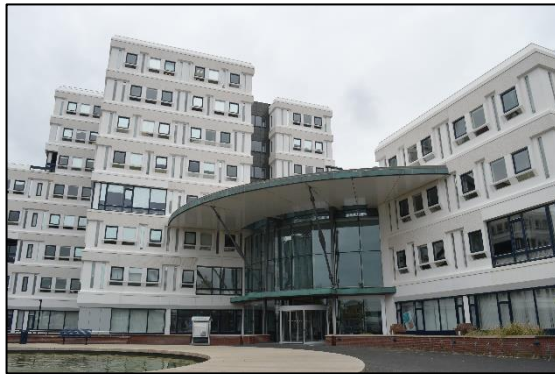
Afbeelding 2.2. Hoofdingang pand met atrium, gezien vanaf zuiden.
