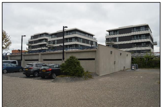
Afbeelding 2.7. Parkeergarage ten noorden van pand.
