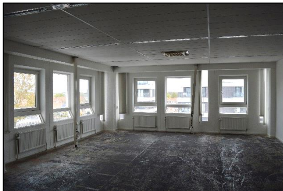
Afbeelding 2.12. Binnenzijde van een kantoorruimte.
