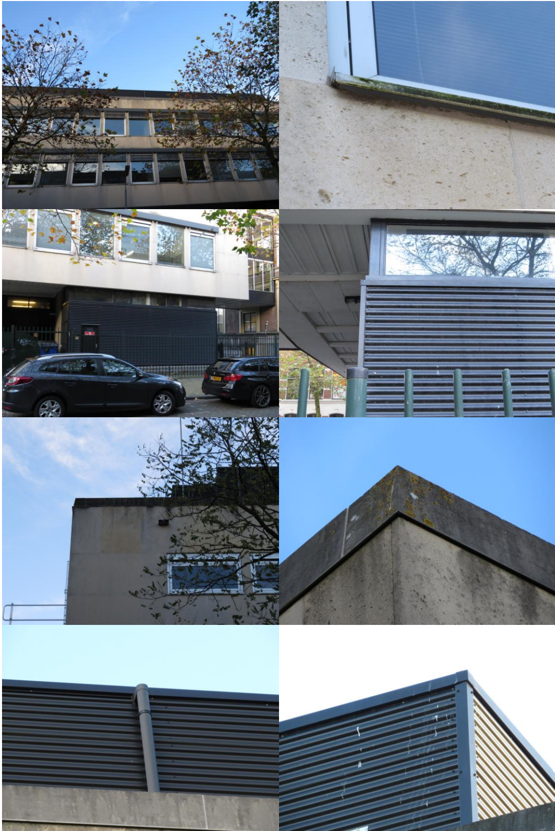
Foto's 1 t/m 8. Van boven naar beneden en van links naar rechts: 1 de gevelbeplating, 2 de overgang van gevelplaat naar kozijn, 3 golfplaat op de begane grond, 4 close-up van de beplating op de begane grond, 5 de overgang van gevel naar dak, 6 close-up van de overgang van gevel naar dak, 7 en 8 constructie op het dak (tweemaal) (foto's A&W).
