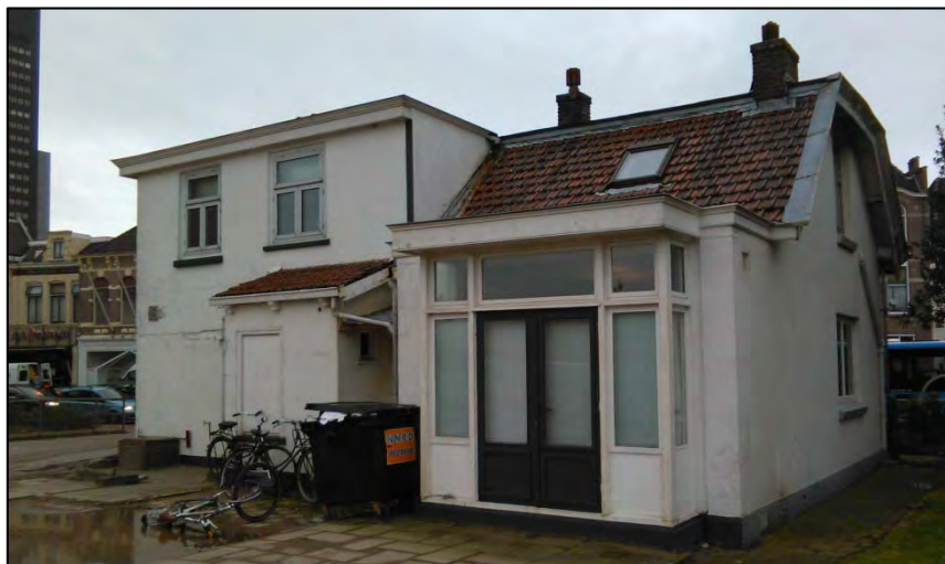
Afbeelding 1: Foto pand Stationsweg 15 (achterzijde)
