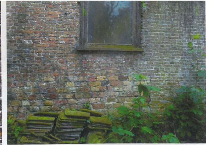
Het oudste muurwerk van de kelder onder de opkamer hergebruikte kloostermoppen is zichtbaar in de noordmuur van het woongedeelte.
