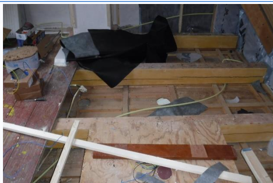
33 | Vloer en plafond
