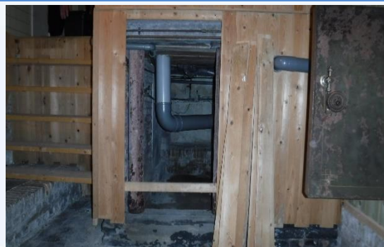
8 | Overzicht kelder/locatie bron
