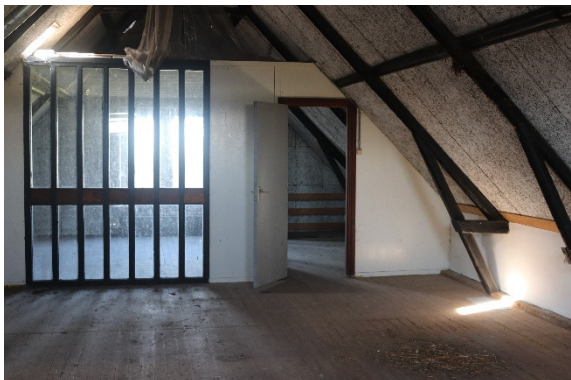
Foto 1: Bovenverdieping oude stierschuur
