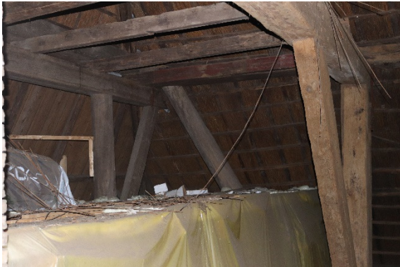
Foto 7: Verdieping in romp van de boerderij
