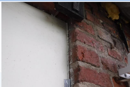
13 | Kitmateriaal naast kozijn
