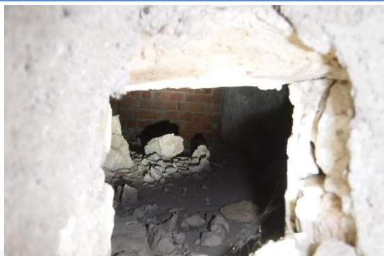
39 | Kruipruimte; geen toegang
