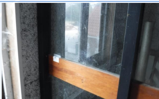
21 | Kitmateriaal binnen kozijnen
