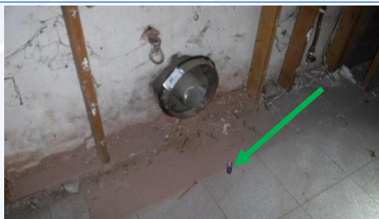
11 | Kleefmonster (KL01) geen asbest
