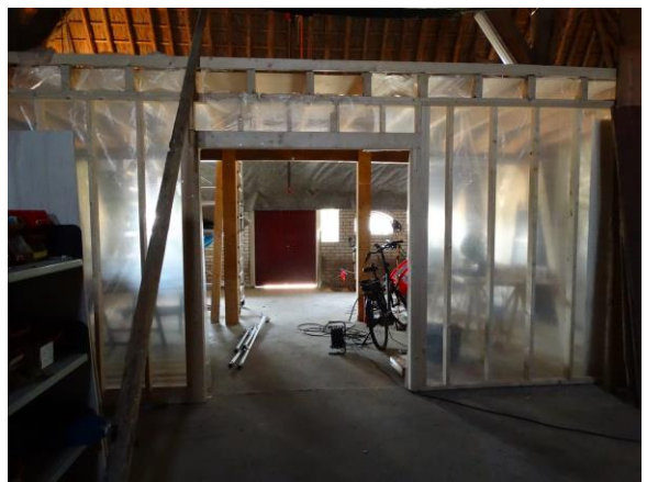
Figuur 5: Het gedeelte dat zal worden verbouwd naar ijschepperij.
