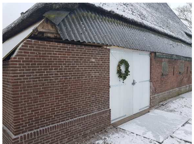
Foto 06: Achtergevel ter hoogte van de timmerwerkplaats.
