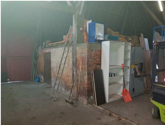
Foto 13: Interieur stal met zicht op het lyts bûthus
