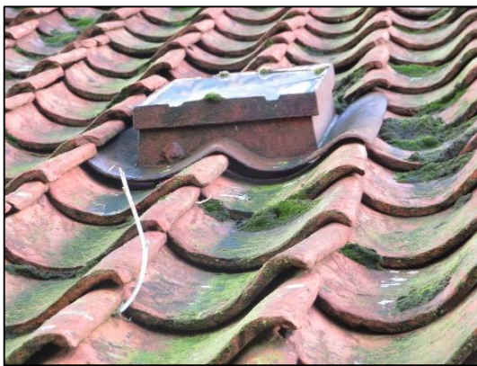
afbeelding 2.4. Dakpannen met dakraam.
