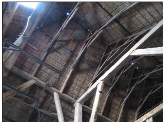
afbeelding 2.7. Rieten dak aan de binnenkant van de schuur.
