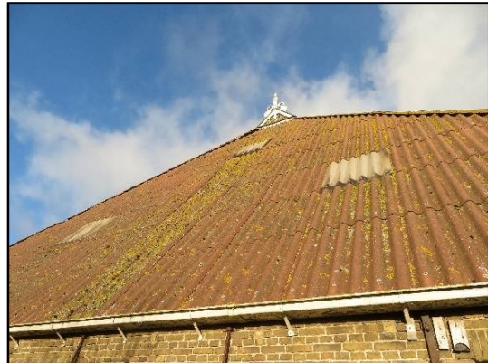
afbeelding 2.3. Schuine dak van de schuur.
