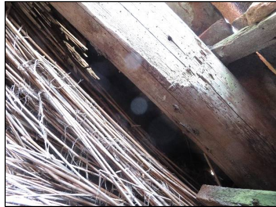
afbeelding 2.9. Rietdak (detail binnenkant).
