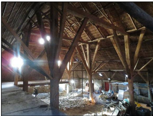
afbeelding 2.6. Overzicht binnenkant van de schuur.
