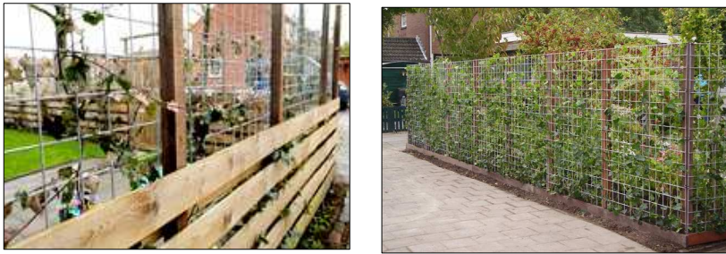
Figuur 2. Voorbeelden van terrein- en erfafscheidingen met een open gasconstructie
