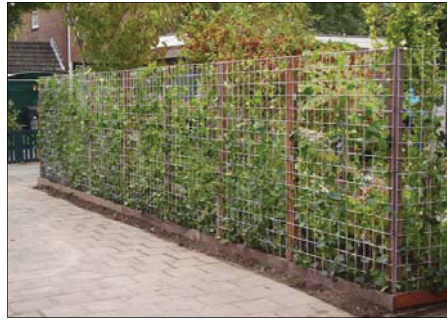
Figuur 7. Voorbeelden van terrein- en erfafscheidingen met een open gaasconstructie
