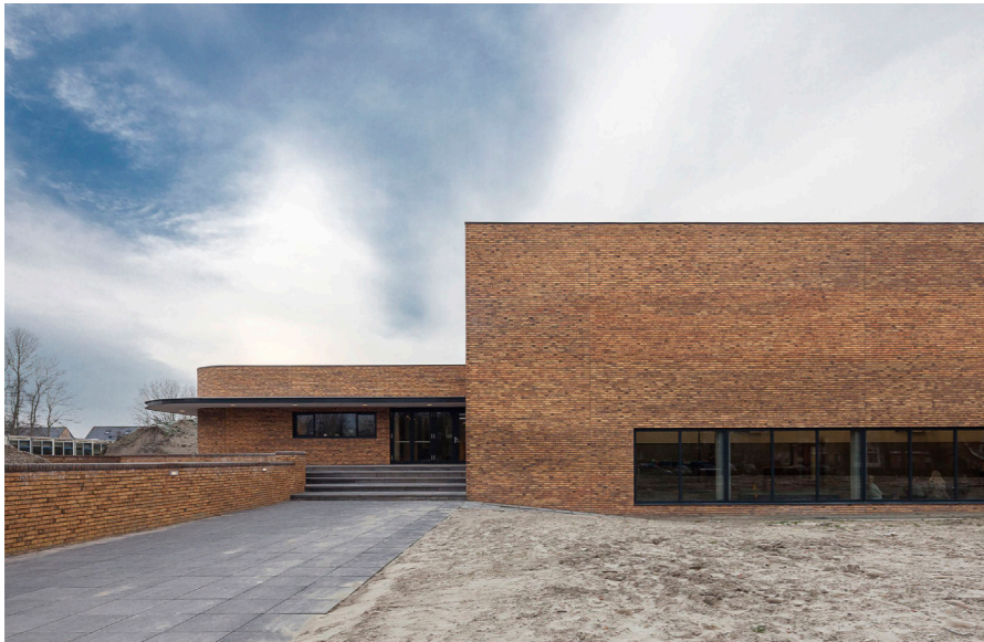
Contrasten tussen open en gesloten gevelvlakken Hogeland College Warffum - ADP Architecten
