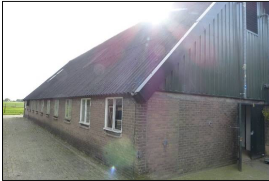
Afbeelding 2.4. Te slopen schuur gezien vanaf noorden.
