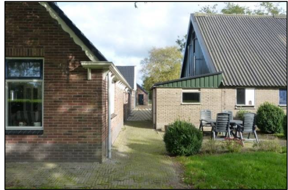
Afbeelding 2.5. Woonhuis en te slopen schuur.
