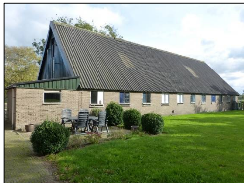
Afbeelding 2.3. De te slopen schuur gezien vanaf westen.
