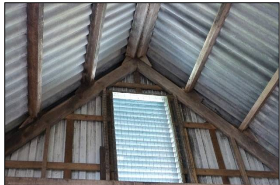
Afbeelding 2.7. Binnenkant dak, schuur.
