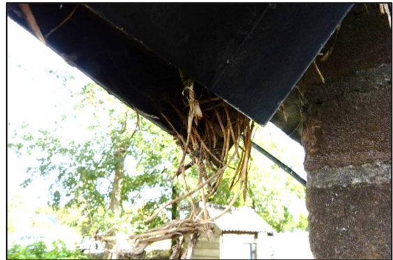
Afbeelding 2.9. Uitstekend stro, dakrand schuur.
