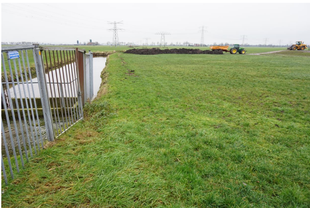
Figuur 2.3. Onderzoekslocatie gezien vanaf het zuiden.
