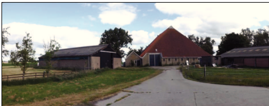
Plangebied gezien vanaf de zuidzijde met links de kapschuur, rechts de koeienstal en in het midden de stolpboerderij met aanbouw.
