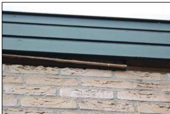
Afbeelding 3.1. Opening dakrand noordzijde.
