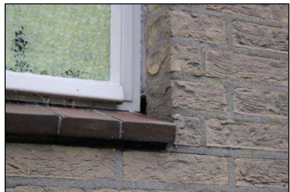
Afbeelding 3.2. Opening bij kozijn noordzijde.
