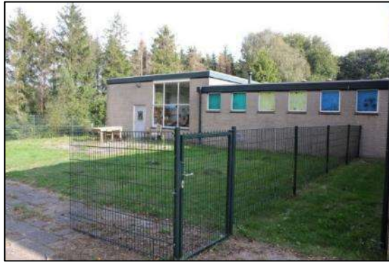
Afbeelding 2.4. Tweede deel noordzijde gebouw.
