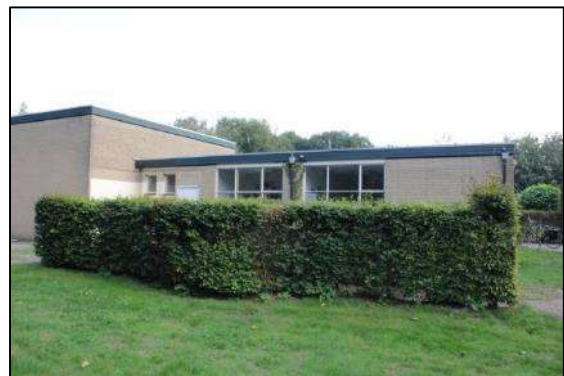
Afbeelding 2.3. Eerste deel noordzijde gebouw.
