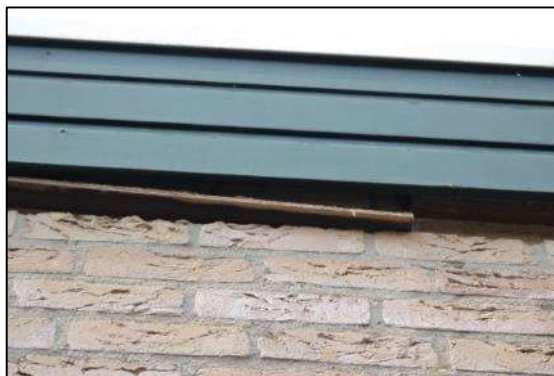
Afbeelding 3.1. Opening dakrand noordzijde.
