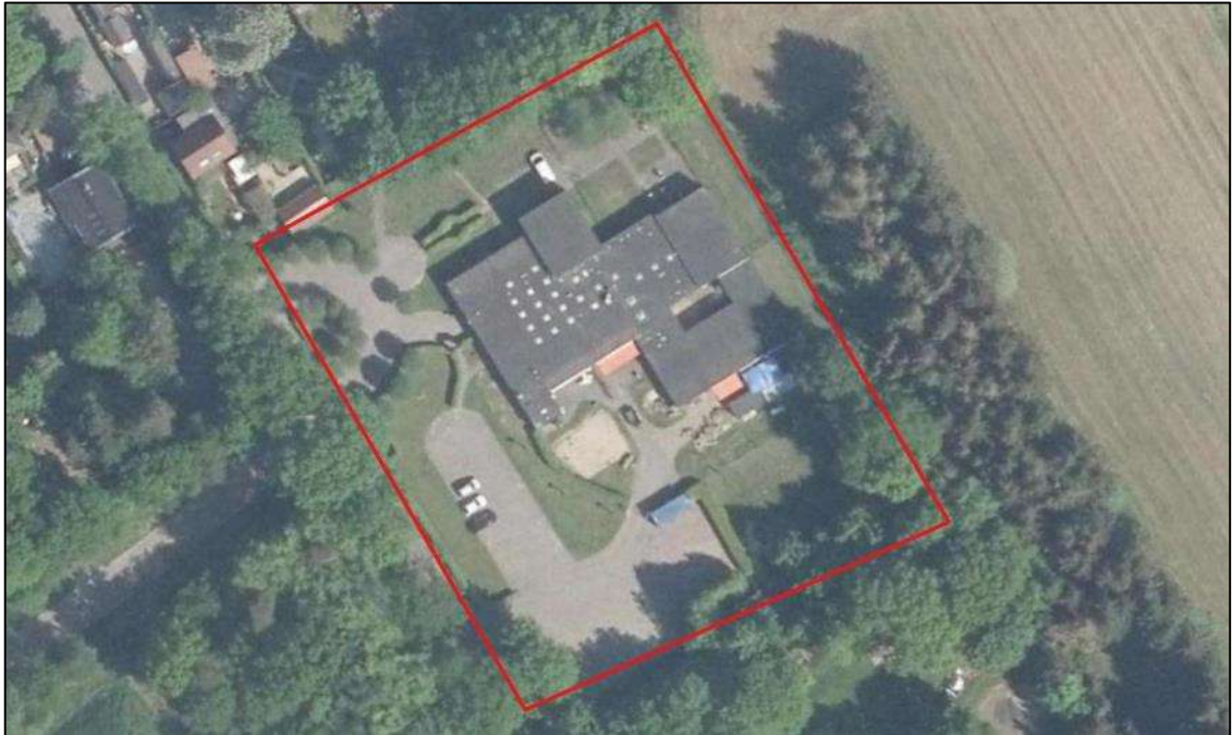
Afbeelding 2.1. Plangebied, de te slopen gebouwen zijn met rood gearceerd (bron: ESRI).
