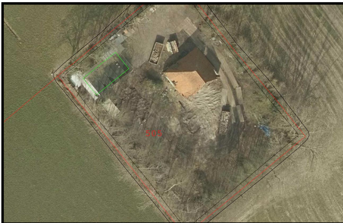
Figuur 5. Luchtfoto van de sloop. Bron: Twan's Landschaps- en Tuinadvies.
