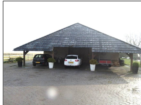
afbeelding 2.5. Bijgebouw vanaf de westzijde.
