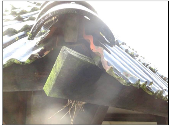
afbeelding 2.9. Losse dakpannen op de hoek.
