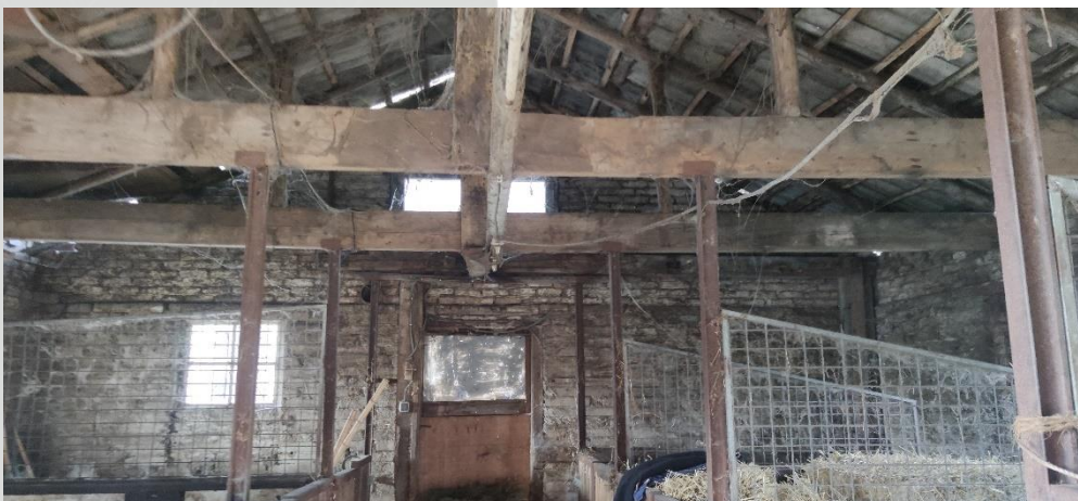
Figuur 6: houten balken binnen in de schuur
