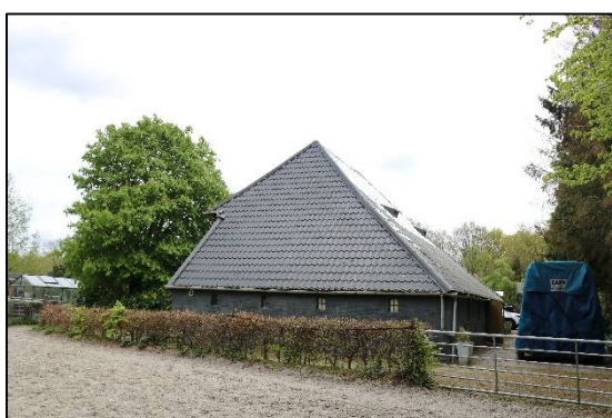
Afbeelding 2.5. Te slopen schuur vanaf noorden.
