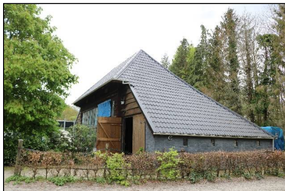
Afbeelding 2.2. Te slopen schuur gezien vanaf zuiden.
