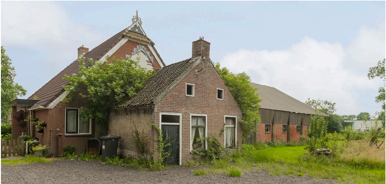
foto: bebouwing Bospad 8
