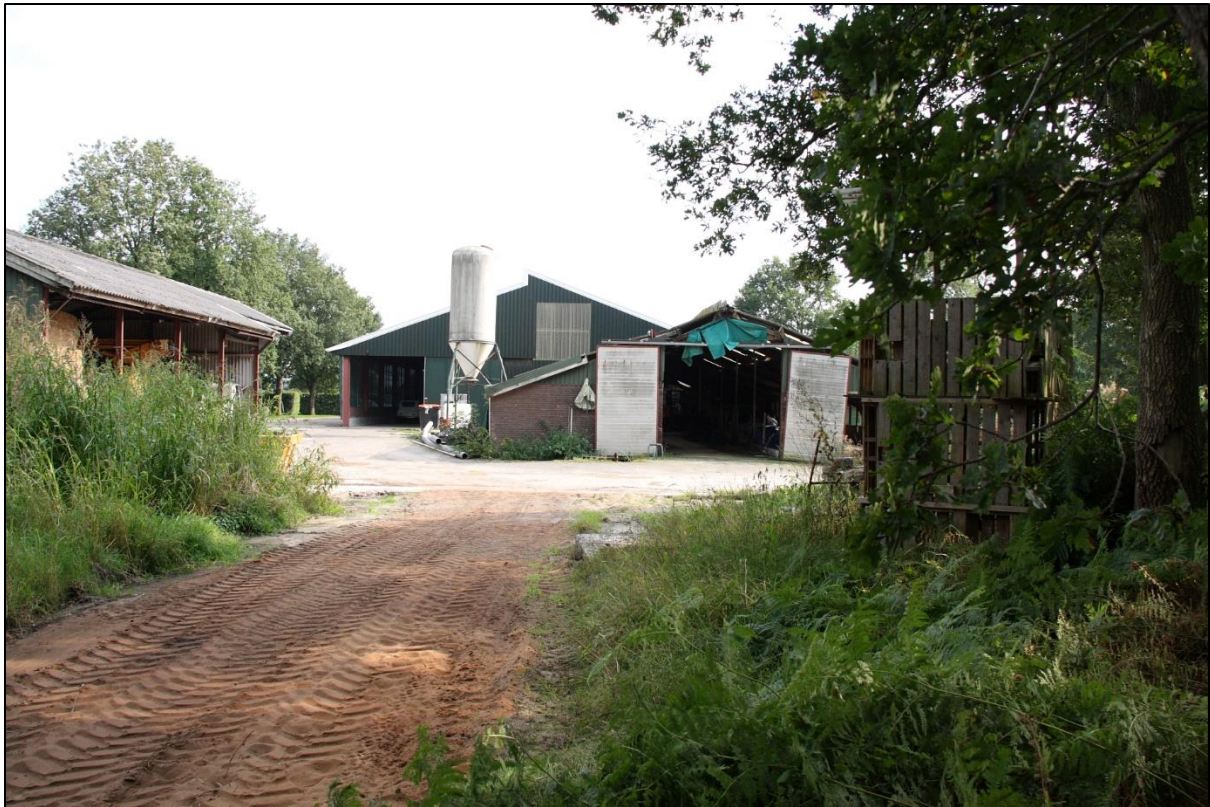
Figuur 5. Overzicht van de te slopen bedrijfsgebouwen op de locatie
