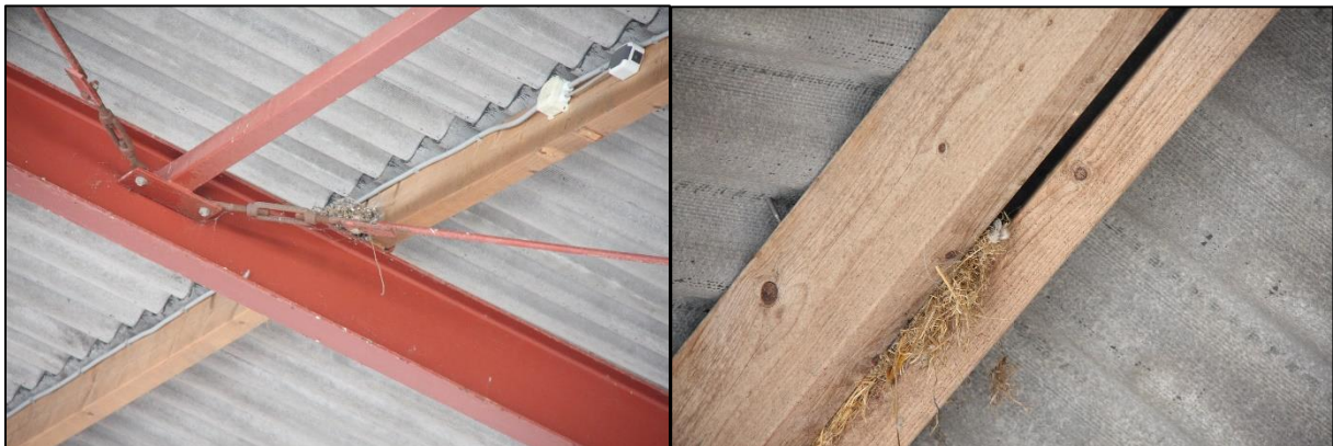
Figuur 14. In de bedrijfsgebouwen zijn enkele nestplekken gevonden die mogelijk door huismus gebruikt kunnen worden
