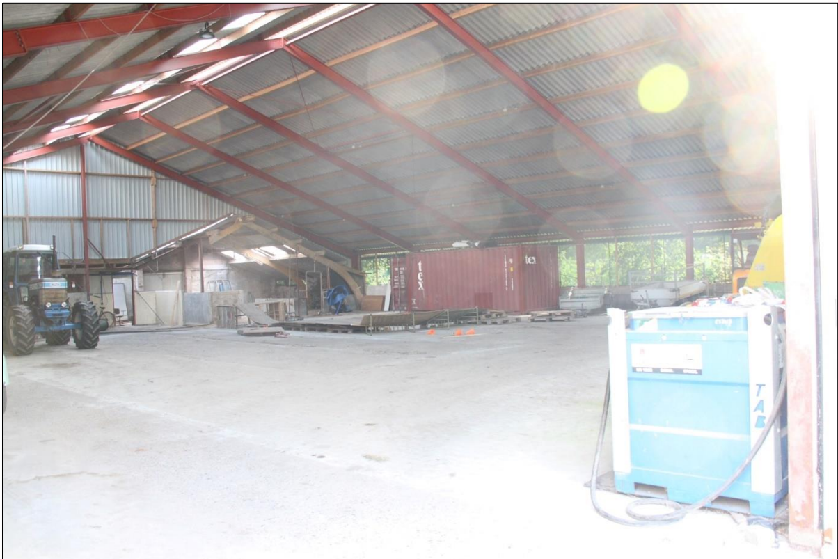
Figuur 10. Binnenzijde van de grote schuur
