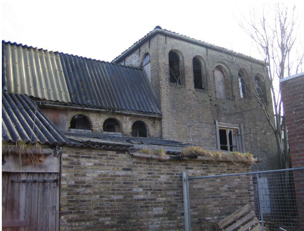
De voormalige leerlooierij aan de Gedempte Molenwijk. Dit gebouw is één van de gebouwen waar mogelijk verblijfplaatsen van vleermuizen aanwezig zijn (foto A&W).
