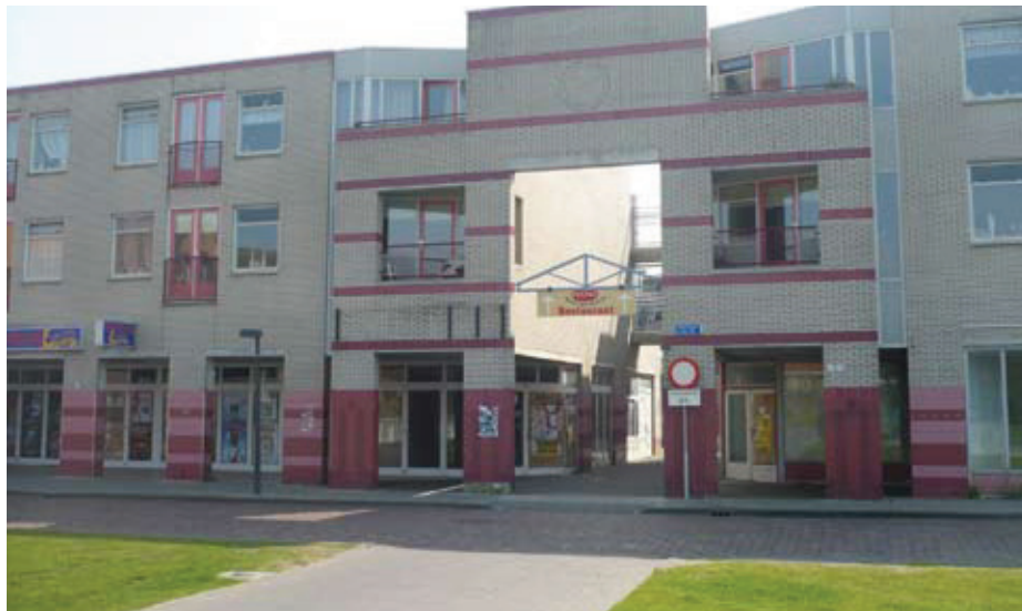
Wand Geerts Willigenplein en Schoolsteeg
