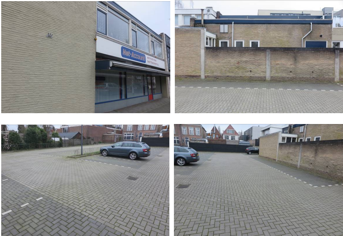
Figuur 2. Foto-impresie van de te slopen opstallen aan de Nieuwstraat te Heerenveen.
