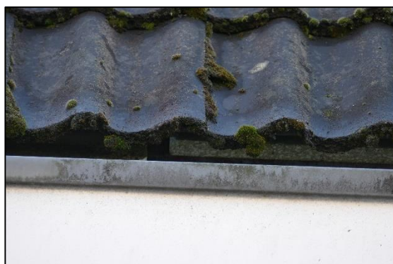
Afbeelding 2.8. Isolatiemateriaal onder dakpannen.
