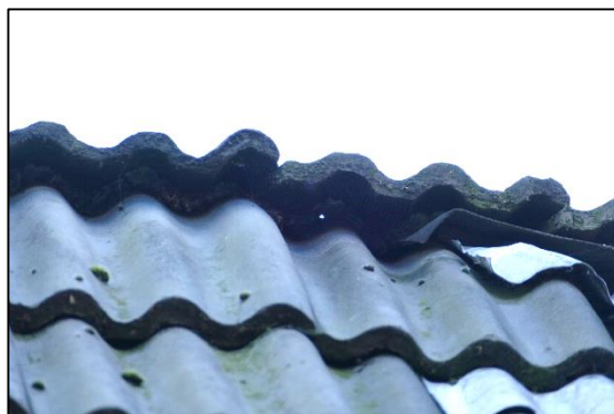
Afbeelding 2.7. Onderkant van dakpannen afgedicht.
