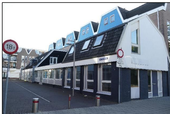
Afbeelding 2.2. Overzicht van het pand vanuit het westen.
