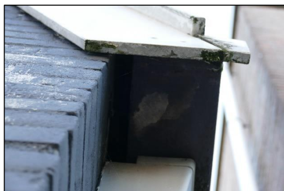
Afbeelding 2.9. Open ruimte bij regenpijp.
