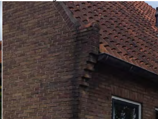
bestaande gemetselde 'oren' op kopgevels
