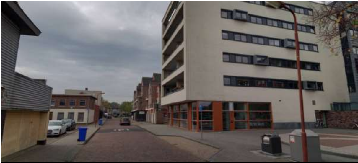
Figuur 2. Bestaand straatbeeld Kerkstraat vanuit het oosten
