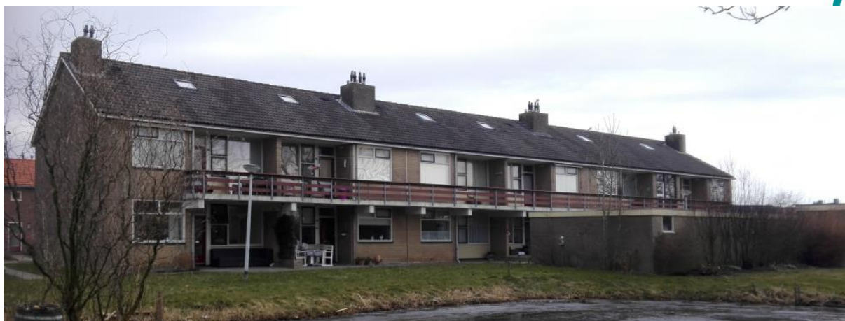
Figuur 2.2. Achterzijde van de woningen aan de Rakswâl 17 tot en met 27.
