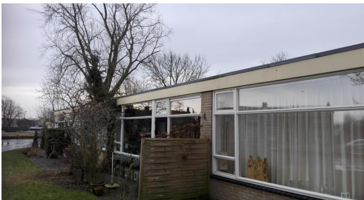
Figuur 2.4. Achterzijde van de woningen aan de Rakswâl 9 tot en met 15.
