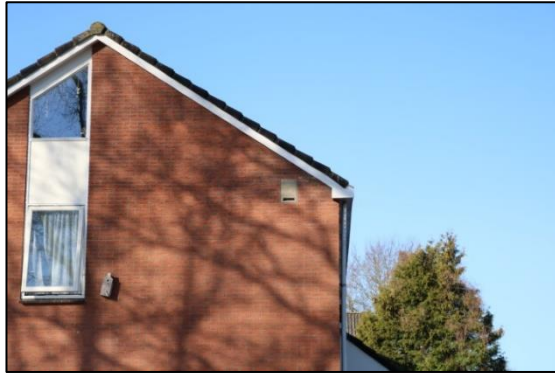
Afbeelding 3.3. Inbouwsteen voor vleermuizen, westzijde plangebied.
