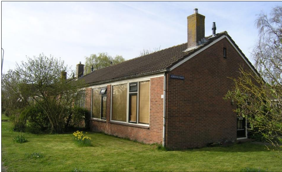
Deelgebied 2 – Woningen aan de Frittemastraat in Midlum (5 april 2017)
