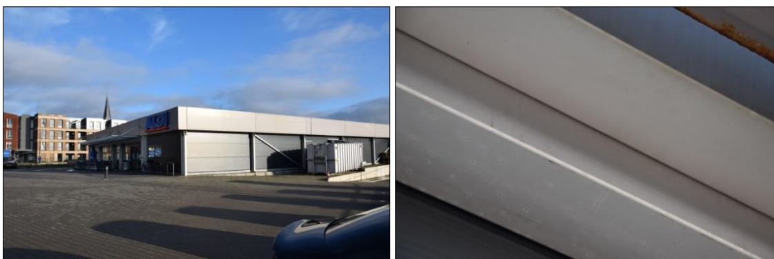
Foto's 1 en 2. Impressie van het plangebied op 8 december 2021. Links het aanzicht op de zuidwestzijde van het gebouw vanuit het zuidwesten. Rechts de metalen balken rondom het gebouw waar geen ruimte tussen of achter zit.
