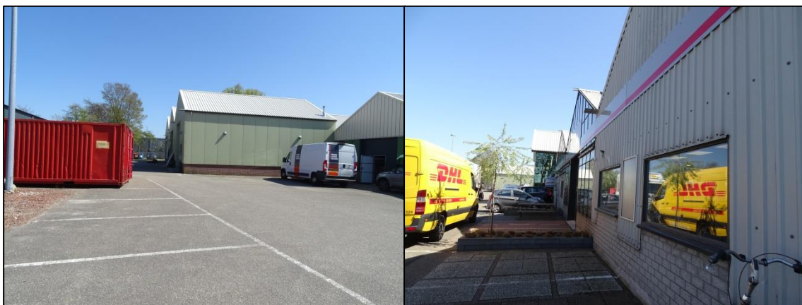
Foto's 1 en 2. Impressie van het plangebied op 22 april 2020. Links het aanzicht op de noordoostzijde van het gebouw vanuit het noordwesten. Rechts het aanzicht op de noordwestzijde van het gebouw vanuit het westen.
