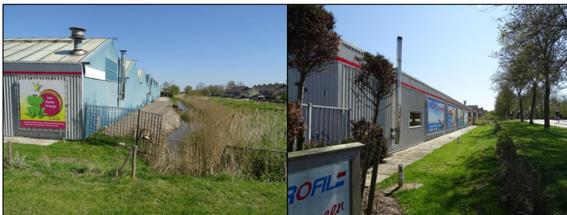
Foto's 3 en 4. Impressie van het plangebied op 22 april 2020. Links het aanzicht op de zuidzijde van het gebouw vanuit het zuidwesten. Rechts het aanzicht op westzijde van het gebouw vanuit het noorden.
