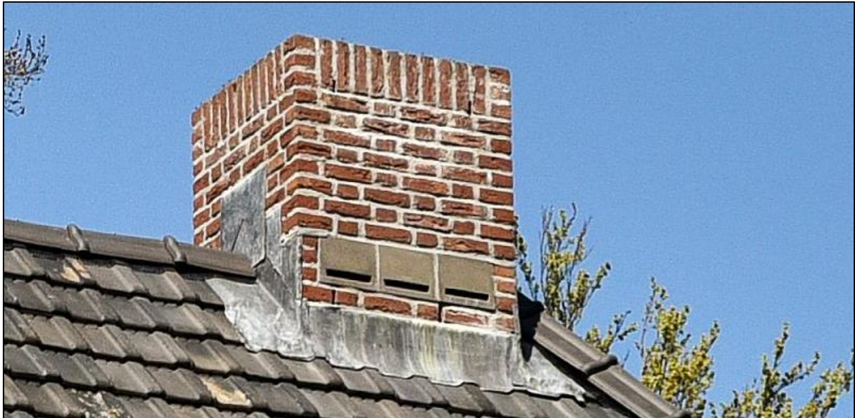
Figuur I1. Voorbeeld van inbouwsteen IB VL 01. Bron: http://www.vivapro.nl/IB-VL-01-Inbouwsteen-Vleermuizen .
