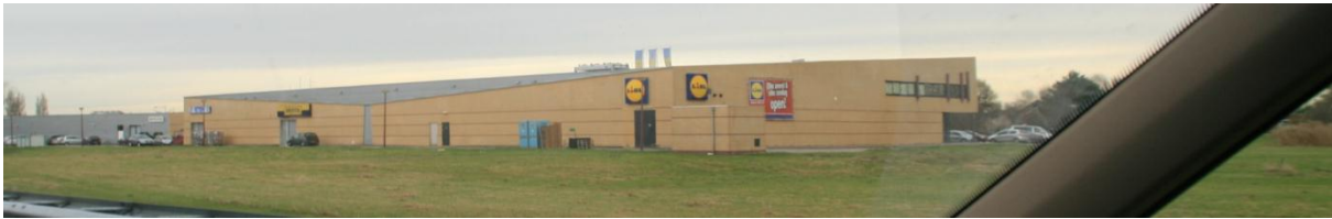
zicht vanaf N31 op karakteristieke en gesloten gevel: achterzijde
