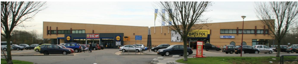
frontaal aanzicht vanaf Kimswerderweg met duidelijke publieksgevel: voorzijde
