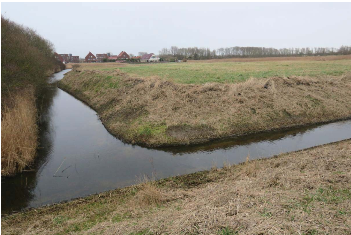
Foto's 1 en 2: impressie van het plangebied. Boven: de Westerzeedijk ter hoogte van de parkeerplaats, kijkend naar het zuiden. Onder: halverwege het plangebied vanaf de Westerzeedijk, kijkend naar het oosten in Harlingen (foto's A&W).
