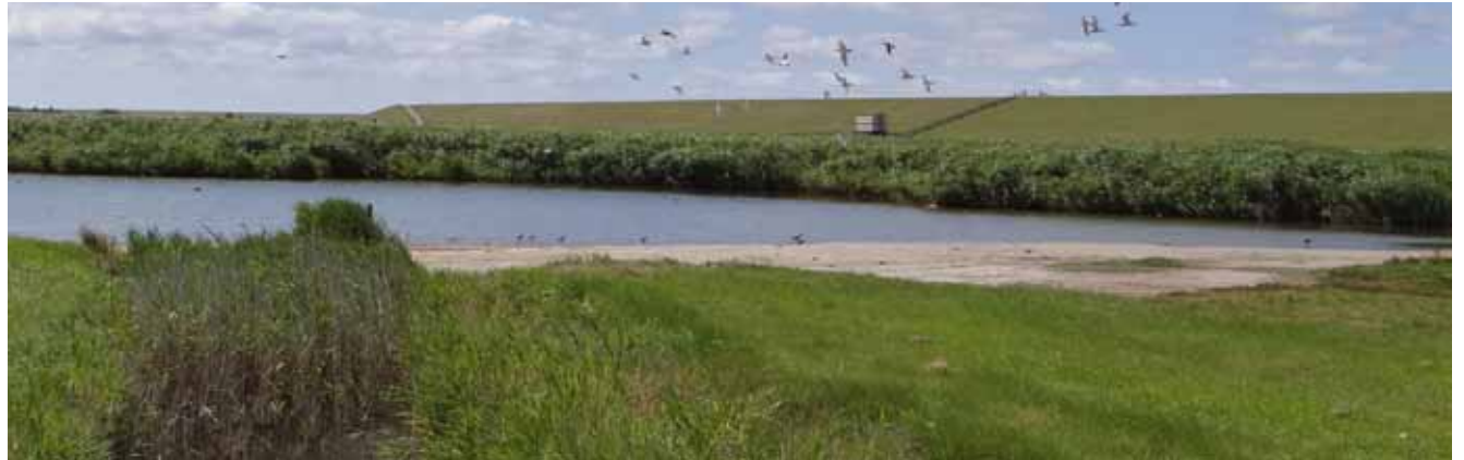
Kleiputten achter de dijk als referentie (Kleiputten Bjirmen)
