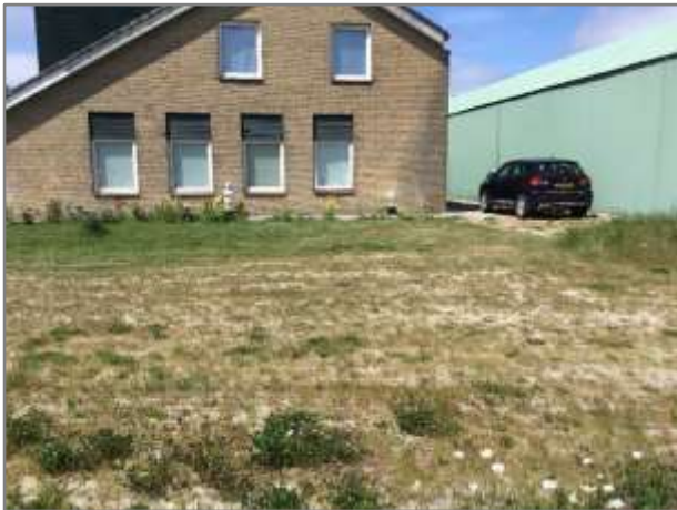
Foto 7: achterzijde romneyloods en gebouw Kimswerderweg 1a
