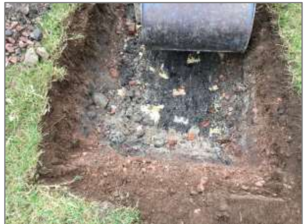
Foto 4: Sleuf 03, laag van 0,3 - 0,7 m -mv
